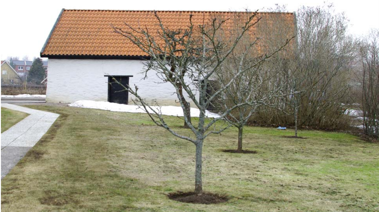
Den gamla magasinsbyggnaden i norr från 1600-talet har ett mycket stort kulturhistoriskt värde
